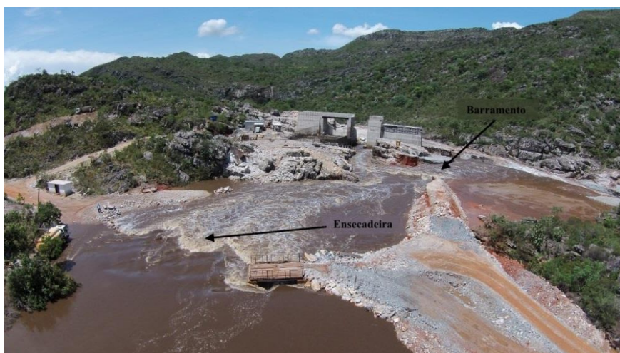
Figura 4: Ensecadeira galgada em consequência de atraso no cronograma, fotografia dos autores.
