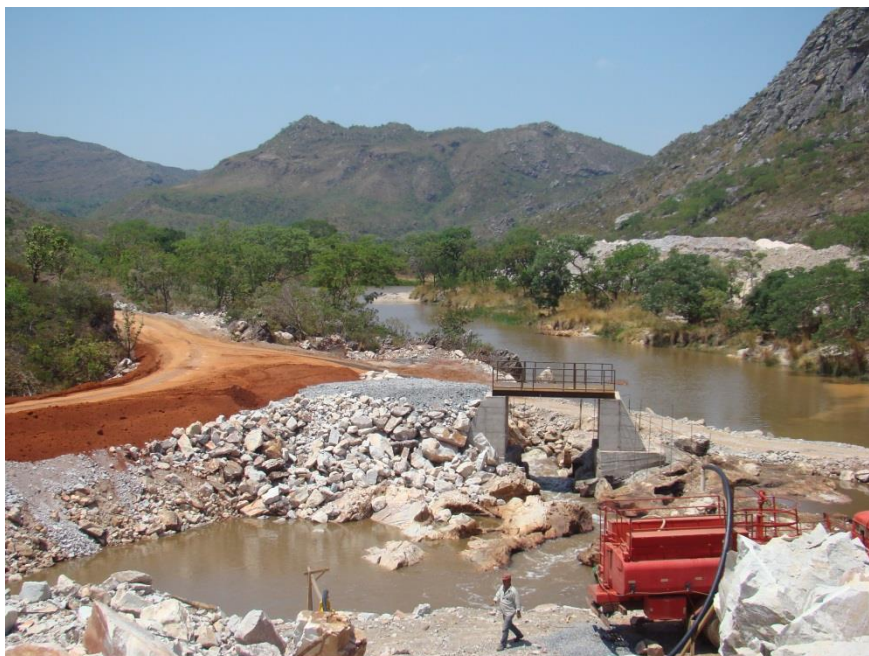
Figura 3: Ensecadeira em conformidade com cronograma, fotografia dos autores.
